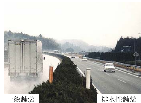
写真1 一般舗装と排水性舗の比較
