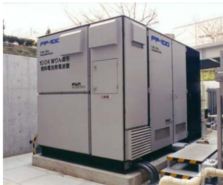
図 100kW リン酸形燃料電池（富士電機）の外観と仕様
