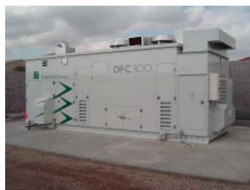
米国 FCE 社製 250kW 級 MCFC 外観
