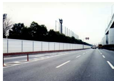
図 TiO 2 光触媒をコートしたNO x 除去機能を有する高速道路防音壁
